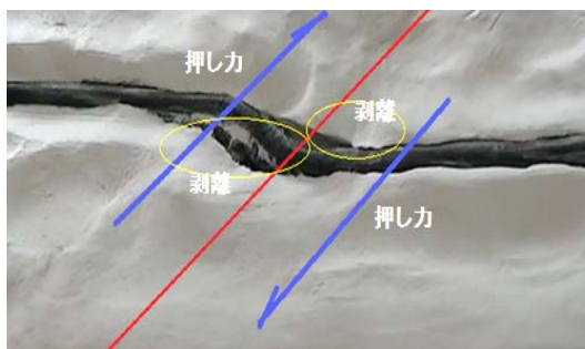
図 9 右ずれ断層変位による管路変形と剥離
