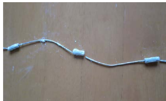
図 11 継手管路本体の座屈
